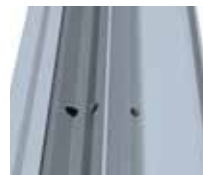
Dränering i rälsprofil
